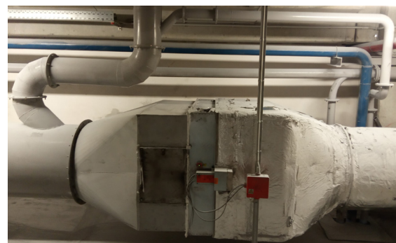
Fig. 4 Fire damper
